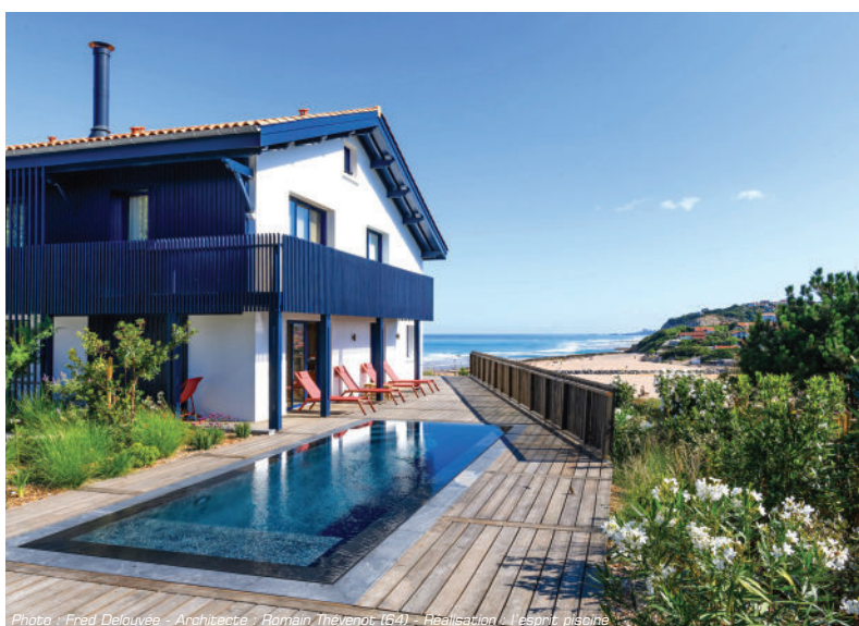
Piscine miroir de 8 m par 2,50 m - fond plat de 1,50 m - revêtement membrane armée 3D 200/100 ème ardoise - escalier d'angle avec banquette sur la largeur opposée - volet immergé.
