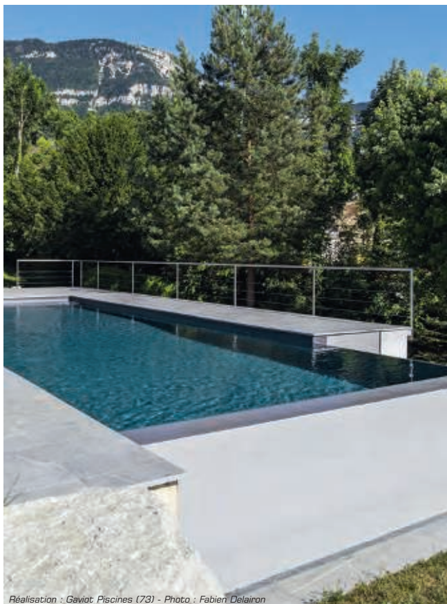
Sur un terrain avec un fort dénivelé, piscine à débordement en béton armé revêtue d'une membrane armée.
