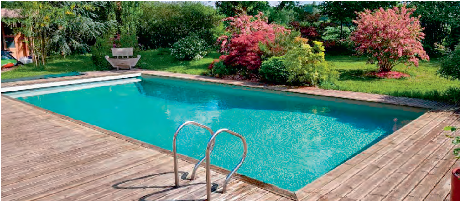
Ce bassin, de forme rectangulaire, est équipé d'un volet immergé. Les margelles et plage sont en bois.
